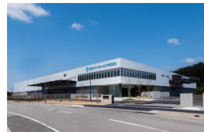
日本ジッパーチューピング 神戸新工場
