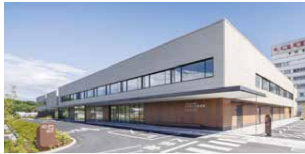
埼玉協同病院リニューアル及び「在宅療養支援病院」建設計画
